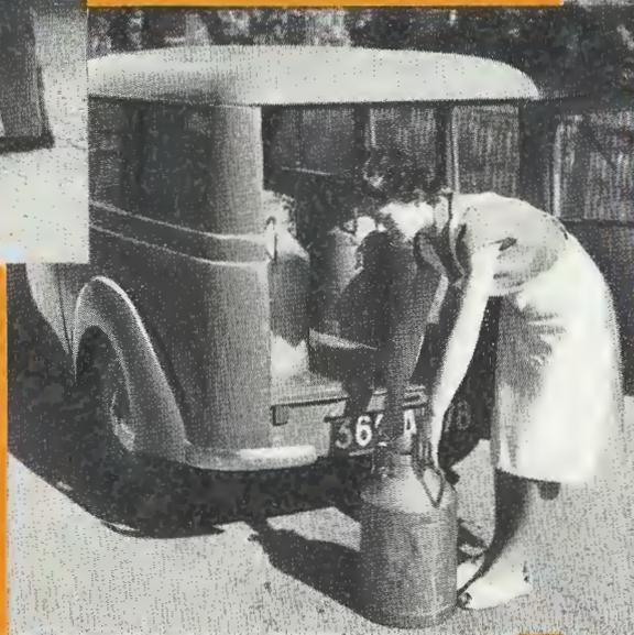
La porte arrière de grandes dimensions (0,90 x 0,82 m) s'ouvre largement. La faible hauteur du plancher au-dessus du sol (0,55 m en charge) permet une manutention sans effort.
